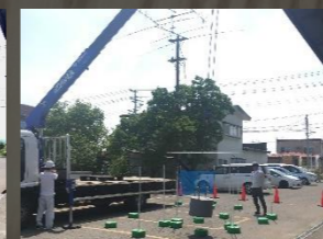
小型移動式クレーン 運転技能講習
